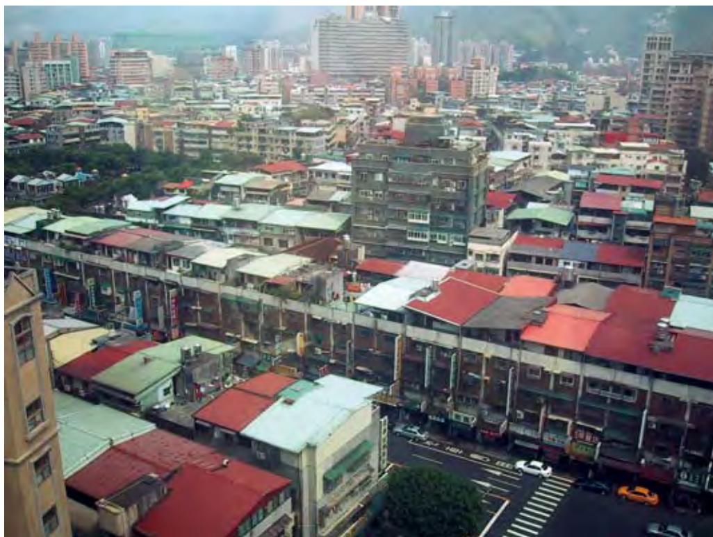
頂樓加蓋大多為鐵皮屋頂
